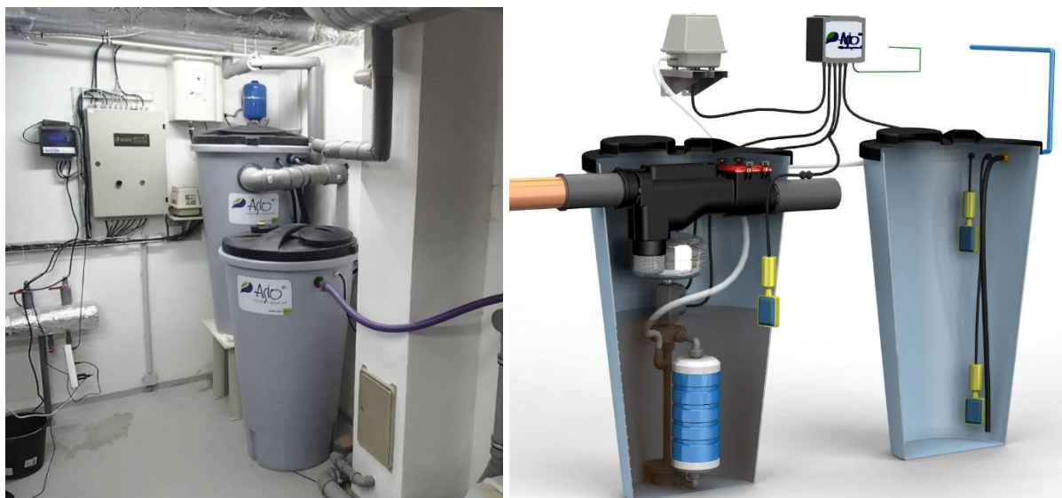
Obr. 2.3 Ukázka jednotky čištění šedých vod AS-GW/AQUALOOP
