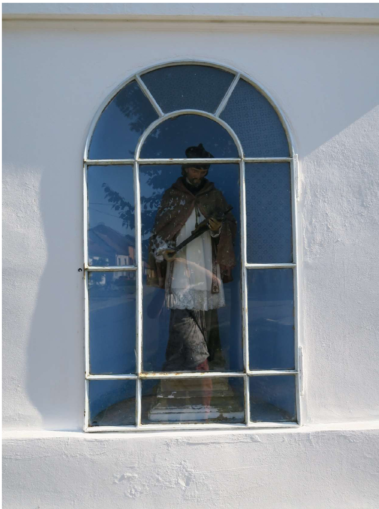
Foto 04 – pohled na ocelové okno na jihozápadě, zasklené v krajních polích ornamentálním pískovaným sklem, v půlkruhové zaklenuté nische socha Sv. Jana Nepomuckého (rozsah doplňovaných pískovaných skel je patrný z výkresové části dokumentace)
