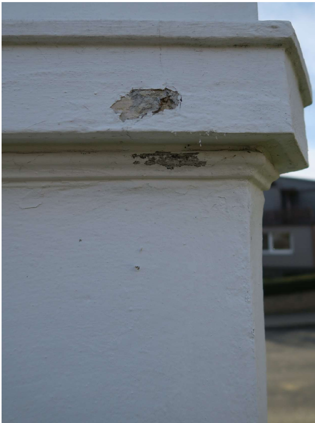
Foto 11 – sonda S04 (stratigrafie) na střední římse na severovýchodní straně objektu)
