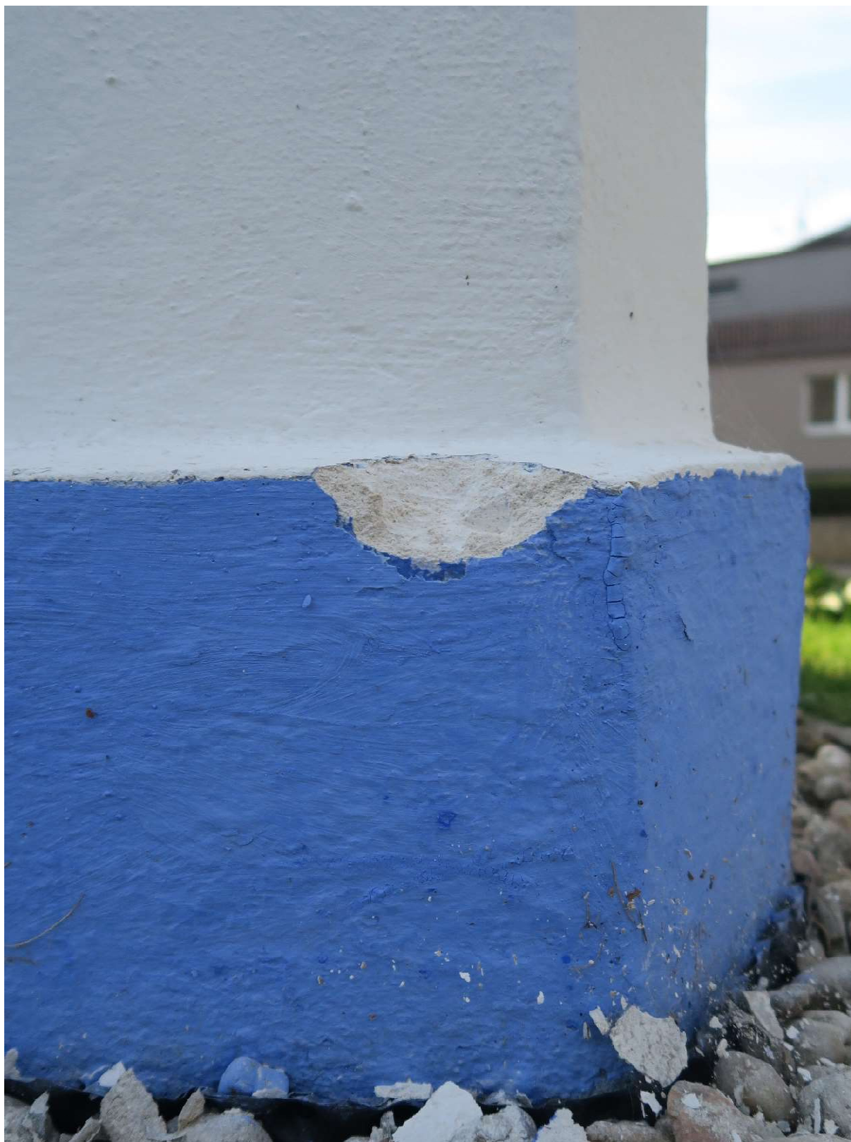
Foto 10 – sonda S03 v rozšířené části soklu těsně nad terénem
