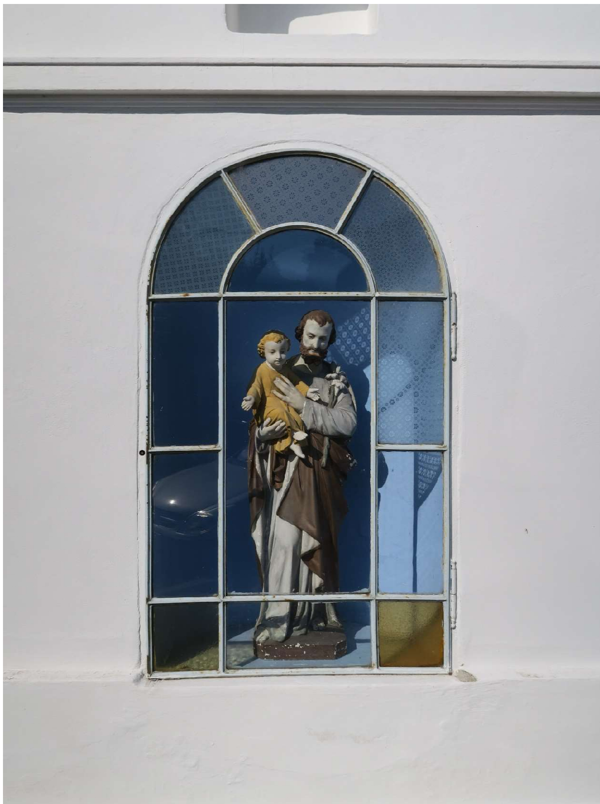
Foto 05 – pohled na ocelové okno na severovýchodě, zasklené v krajních polích ornamentálním pískovaným sklem, v půlkruhové zaklenuté nise socha Sv. Jana Nepomuckého (rozsah doplňovaných pískovaných skel je patrný z výkresové části dokumentace)
