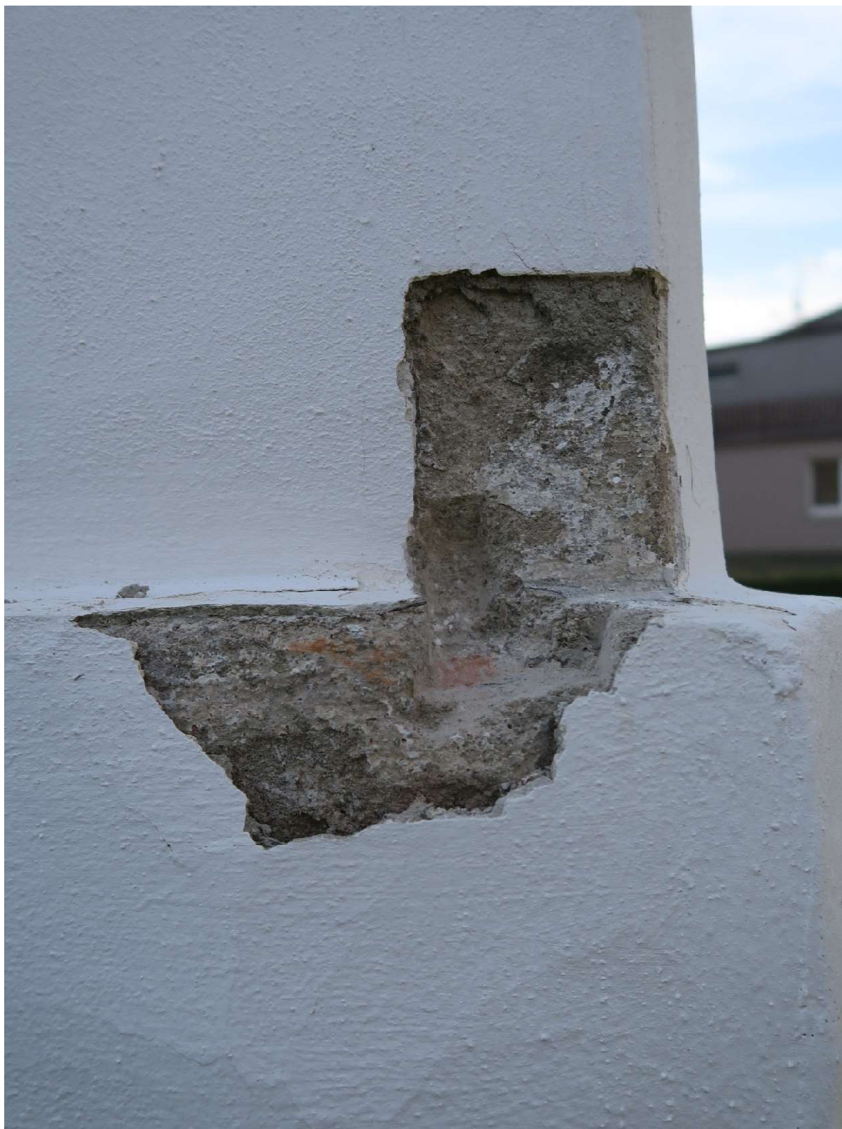
Foto 08 – sonda S01 v horní partii soklové části na severovýchodě. V sondě patrné cementové omítky
