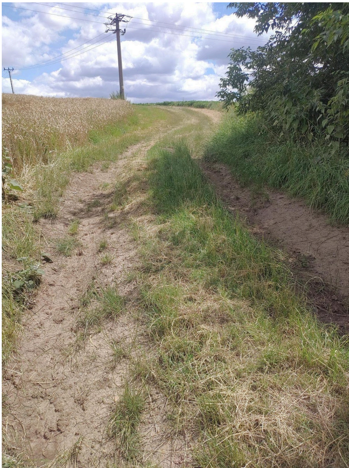
Obrázek 101: Část polní cesty u silnice Kobylnice - Sokolnice-Telnice. Je zde patrná eroze v koleních, která napovídá, že při srážkách dochází k velkému odtoku vody soustředěné v celé délce cesty. (Zdroj: Mapování v rámci studie, 2024)
