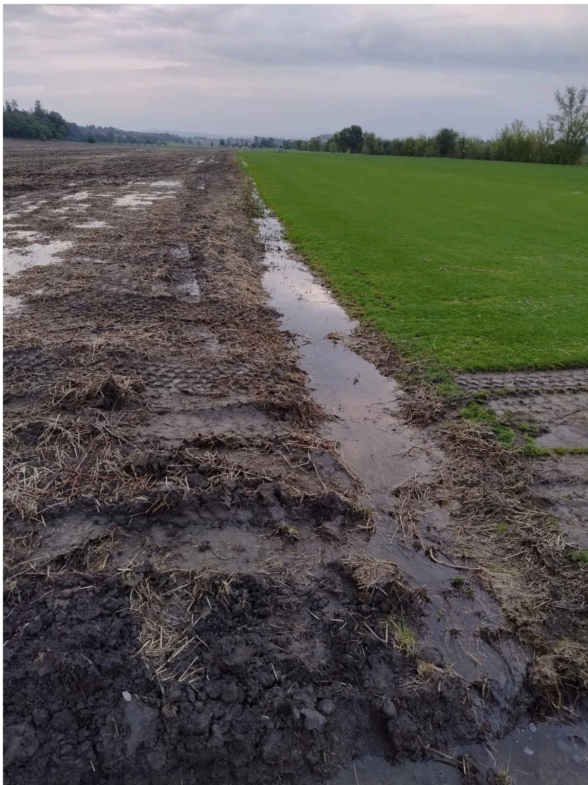
Obrázek 9: Zhutnění půd v lokalitě Na rybníku. Zamokřené plochy po deštích se vyskytují pravidelně. Ve výkopu rekonstrukce odvodnění bylo zřetelné zhutnění jen několik cm pod povrchem. (Zdroj: Mapování v rámci studie 2023 – 2024)
