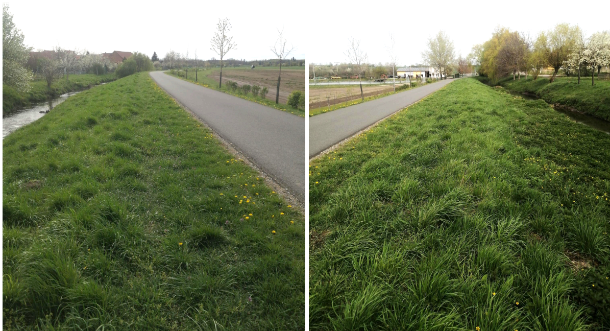
Obrázek 25a a 25b: Pohled na protipovodňovou hráz, která vede v místě původní hráže historického rybníka v pohledu proti toku (obr. 25a) a po směru toku (obr. 25b) v místě ř. km 9,200. (Zdroj: Mapování v rámci studie 2023 – 2024)
